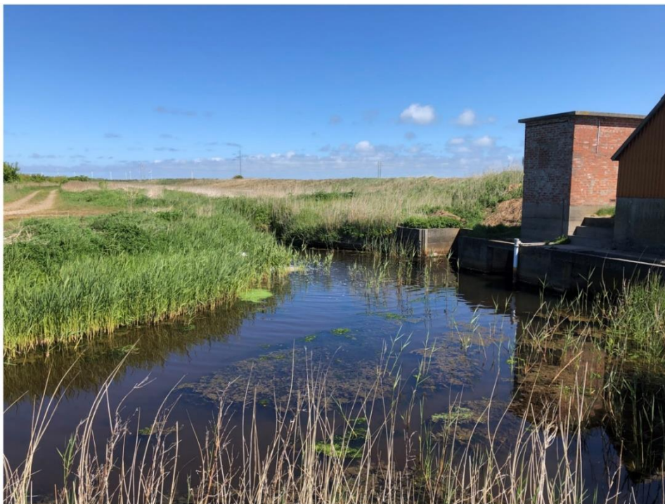
Foto: Det nuværende og fremtidige udledningspunkt fra Harboøre Renseanlæg set fra indersiden af diget med pumpestationen til højre i billedet. Herfra pumpes vandet op i Afvandingskanal ved Sandholm Nor.
