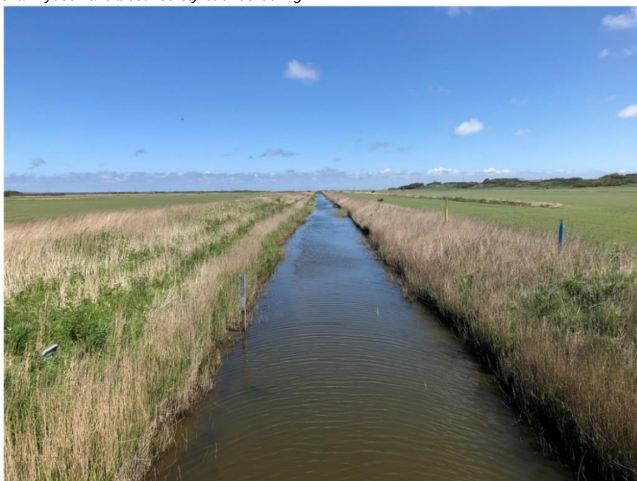
Foto: Ikke målsat afvandingskanal set mod vest fra Thyborønvej. Vandløbet er tilløb til den målsatte sø Hygum Nor. Spildevandsledningen skal krydse vandløbet ved styret underboring ved Pletvej.
