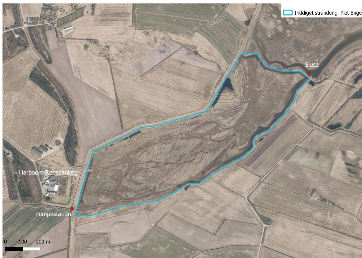
Figur 7.2.8 Den inddigede strandeng ved Plet Enge, umiddelbart øst for Harboøre Renseanlæg, med pumpestation ved renseanlægget der leder vandet til Afvandingskanal v. Sandholm Nor, samt slusen ud mod Nisum Bredning.
