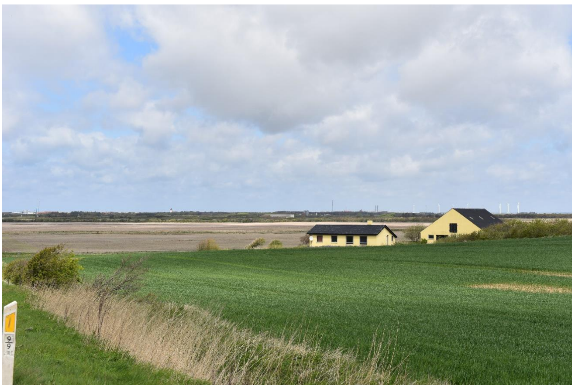
Figur 7.5.9: Fotostandpunkt 2 – Foto af Harboøre Renseanlæg før udvidelsen set fra syd fra Thyborønvej
